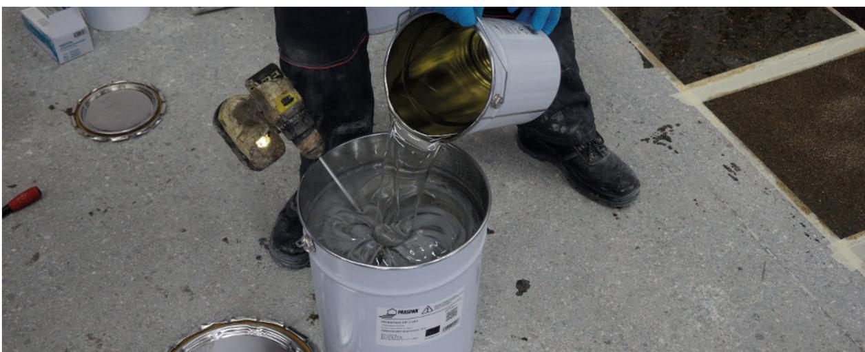
Протекающие реакции идут с выделением тепла, поэтому смесь саморазогревается в объёме (ведре) материала и процесс полимеризации ускоряется. Из этого следует, что время жизни материала в объёме и на поверхности значительно отличается и простой в ведре существенно ограничивает время на обработку материала.
