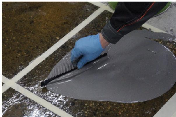
Уровень следует выбирать исходя из расхода материала. Например, при выставленном уровне в 2 мм расход материала составит 2,0 кг на 1м<sup>2</sup>. Нанесение материала удобнее начинать от стены, противоположной к выходу из помещения.
